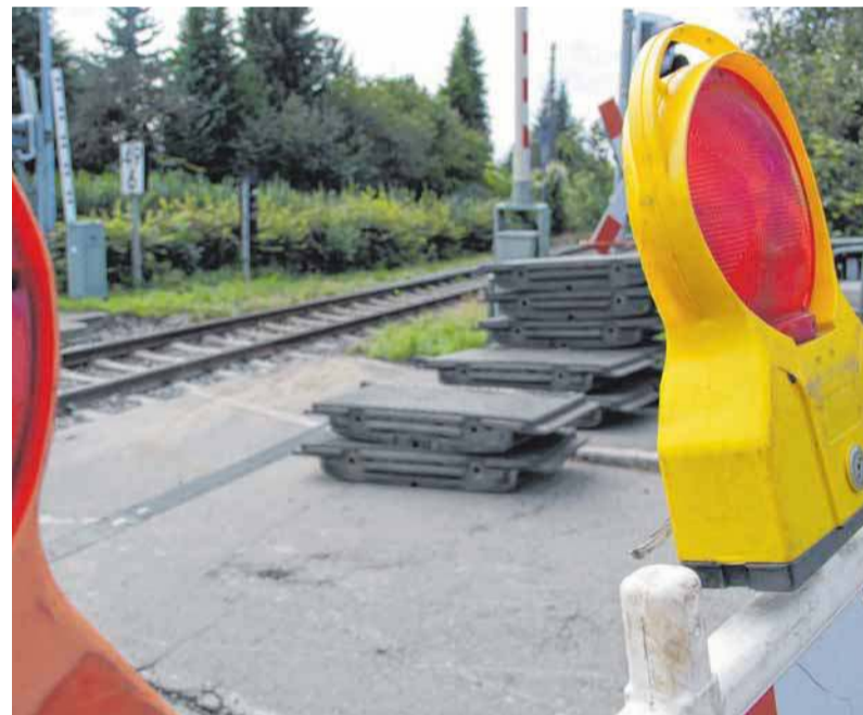
Die alten Platten am Schwanenweg sind schon draußen.
